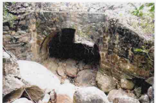
Culvert 176A - Maidenhair Fern Creek
