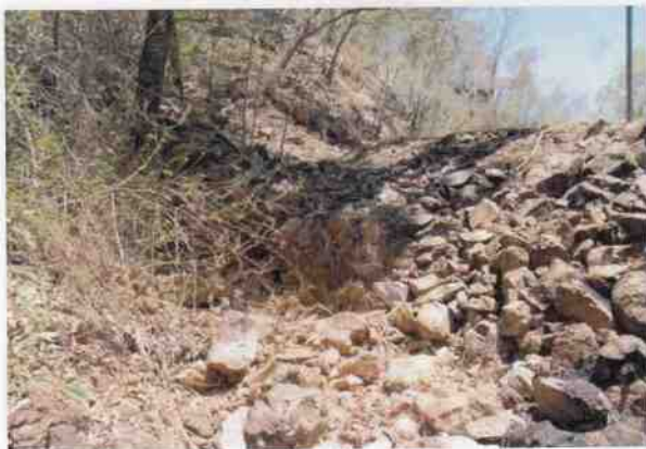
Culvert 196 - Wolfram Creek
