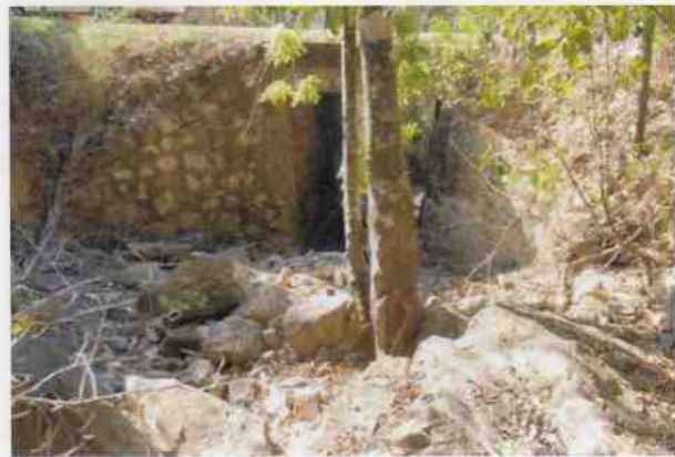
Culvert 141A B141
