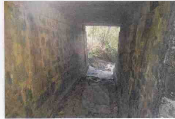
Culvert 141A B143
